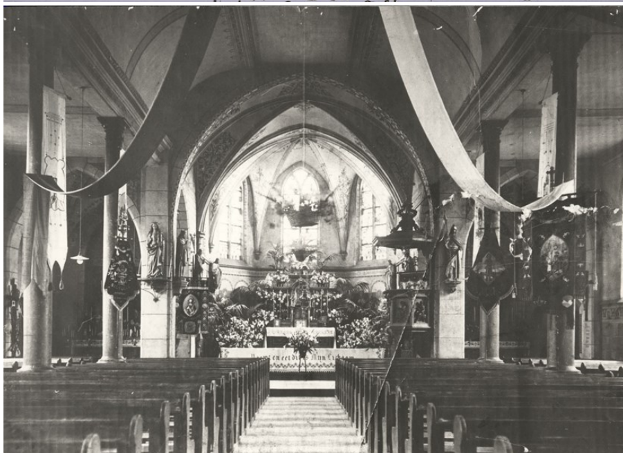
Boven: de pentekening van Maquelin. Onder: een interieurfoto van de Waterstaatskerk uit 1929 waarop de houten pilaren van de driebeukige kerk goed zichtbaar zijn.
