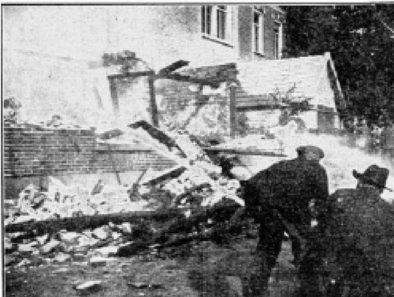
Een kiekje van het blusschingswerk
