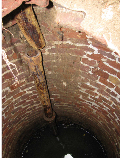
Recente foto van de put, met de gebrooken gietijzeren pijp voor de pompe.
